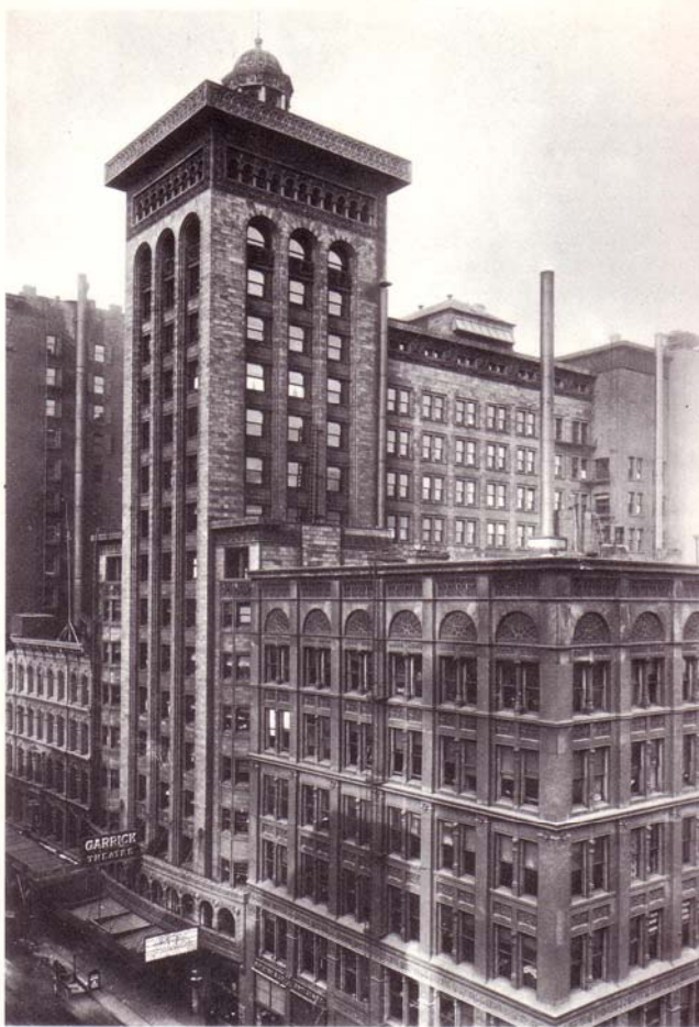
Lo Schiller Building, Chicago (di Adler e Sullivan, 1891-92): all'ultimo piano il primo studio di Wright.
